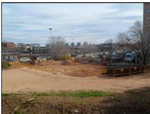
Fig. 89: TERCERA FASE: Diverses vistes dels moviments de terra, en la zona de construcció del nou accés del moll de càrrega. Fotos central, carrer de l'Andana de l'Estació, abans de la construcció del gual. Font: Carles Navarro (2022).
