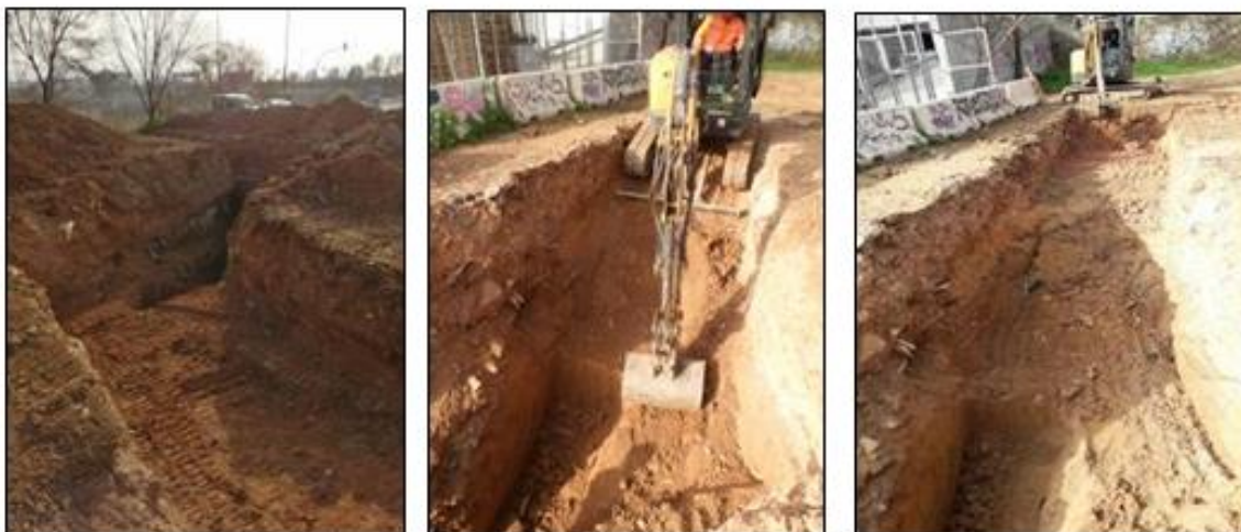
Fig. 32: Diverses vistes de l'obertura de la rasa 300. Font: Carles Navarro (2021)
