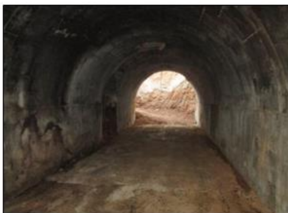
Fig. 14.- Vista general de l'interior del túnel UE.6. Font: Lourdes Moret (2017)
