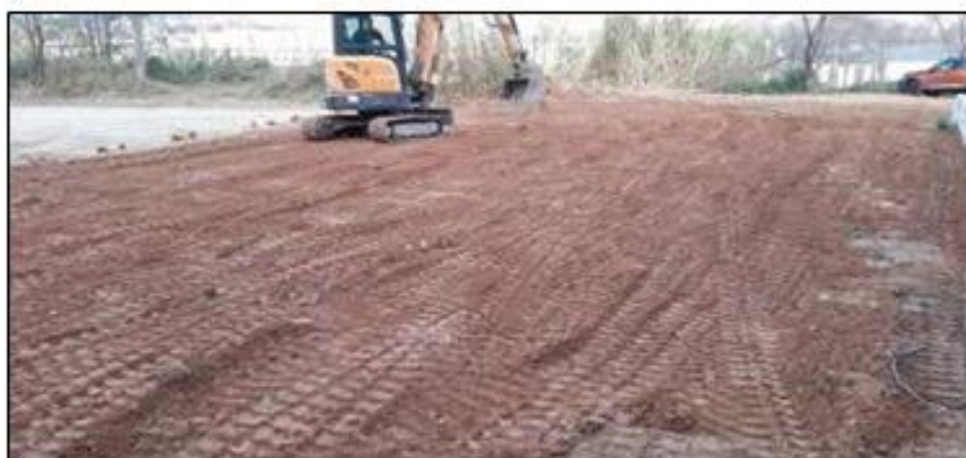
Fig.39: Fotos superiors: A l'esquerra, vista preliminar de la zona afectada abans de l'obertura de les rases. A la dreta, la mateixa zona una vegada reblertes les rases. Fig.40: Foto central i inferior: Vista general de la zona d'obertura de les rases 100, 200, 300, després del seu cobriment . Font: Carles Navarro i Oriol Achón (2021)
