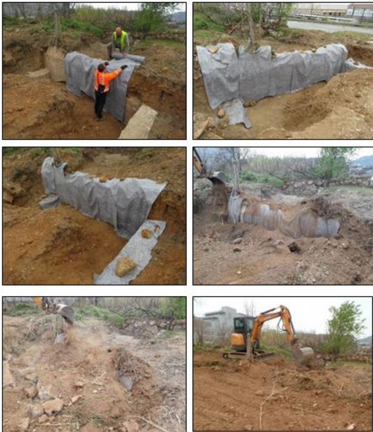
Fig. 35: Vistes del cobriment de la rasa 1 i del Pont del Camí de Santa Coloma. Font: Carles Navarro i Júlia Miquel (2021).
