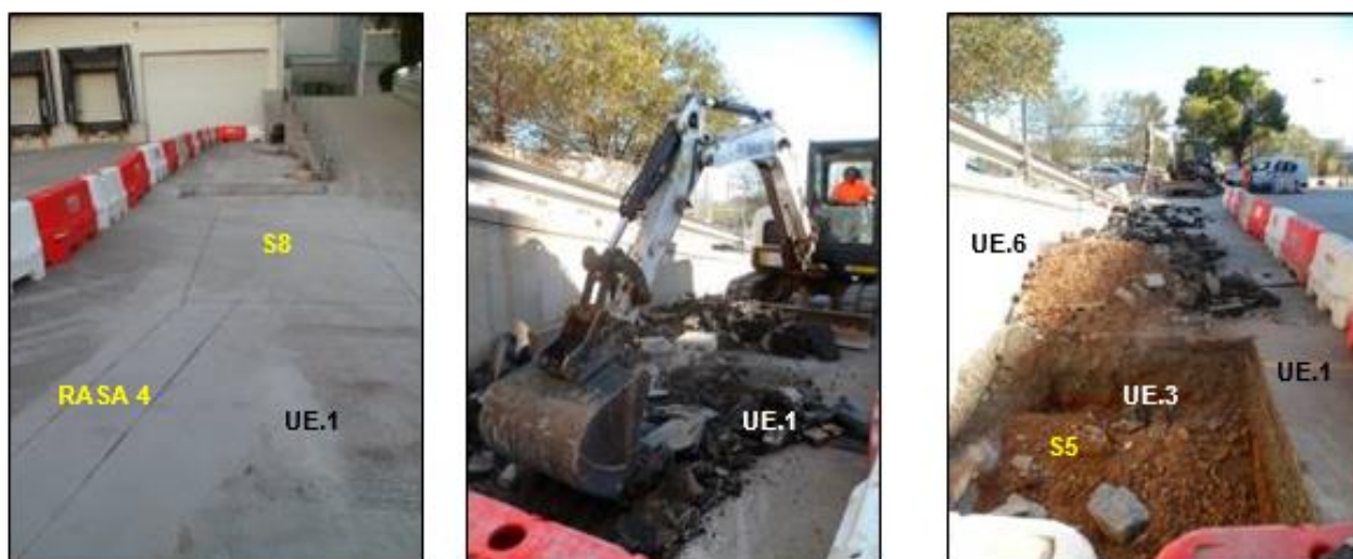
Fig. 53: Sector nord. Situació de les sabates de fonamentació per la construcció del túnel del mur acústic. Obertura de les sabates 5, 6, 7, 8 (S5, S6, S7, S8). Font: Carles Navarro (2021).
