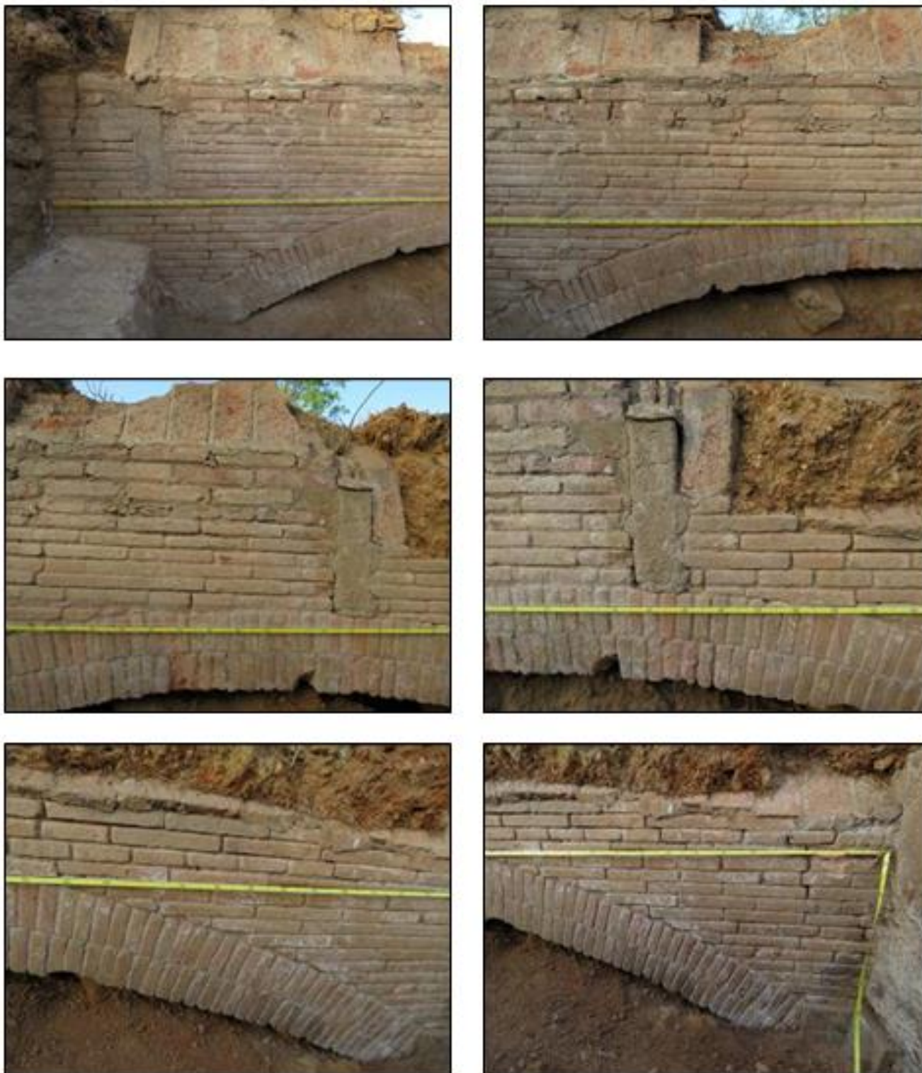
Fig. 22: Diverses vistes del mur sud del pont (UE.5) i de la seva volta de descarrega (UE.6). Font: Jùlia Miquel (2021)
