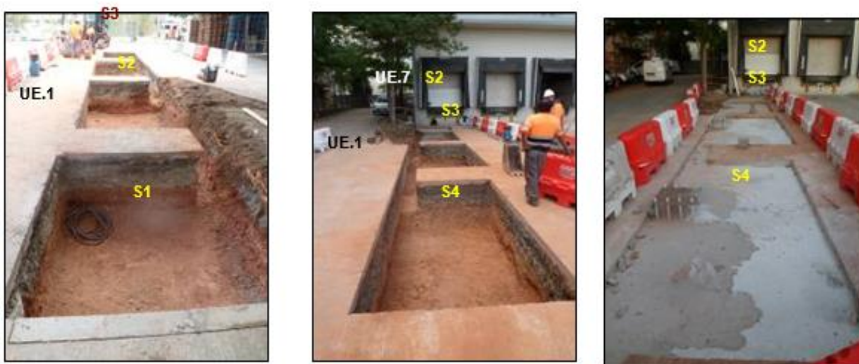
Fig. 49: Sector sud. Vistes de les sabates S1, S2, S3, S4 i la riosta que les uneix. Font: Carles Navarro (2021).
