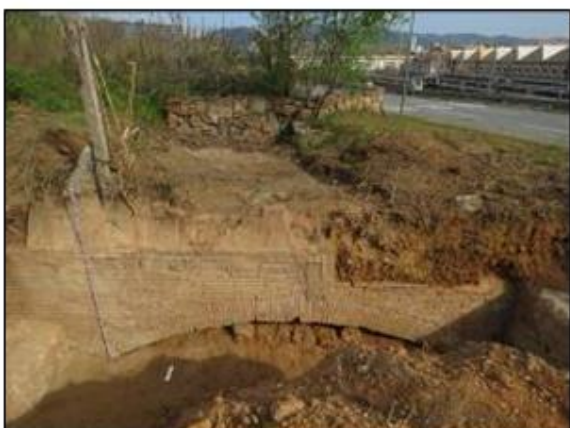
Fig. 20 : Fotos superiors: Neteja del pont del Rec Comtal. Fotos inferiors: Vista del mur sud del pont amb la volta de descarrega i els dos murs paral·lels del rec (UE.10) a la dreta i (UE.11) a l'esquerra. Font: Carles Navarro (2021)
